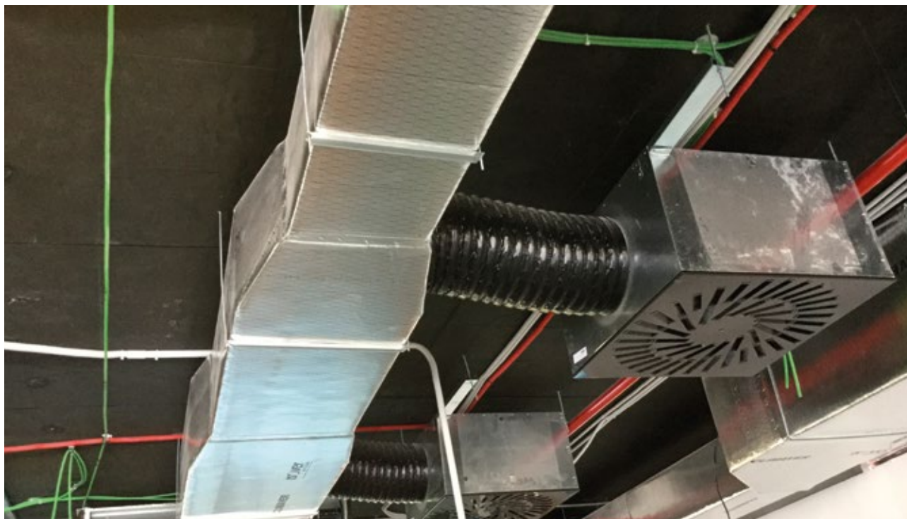
Instalacija CLIMAVER® kanala. Povezivanje sa difuzerom pomoću fleksibilnog kanala
