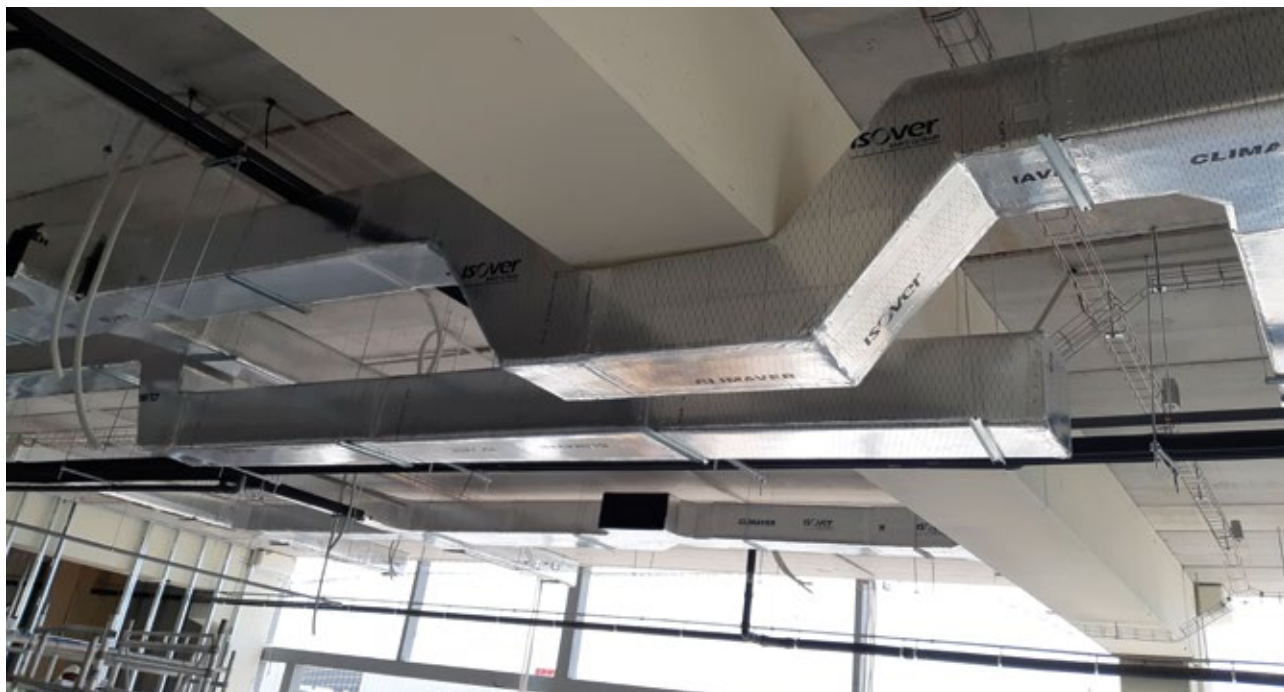
Instalacija CLIMAVER® kanala SDM prolaz grede
