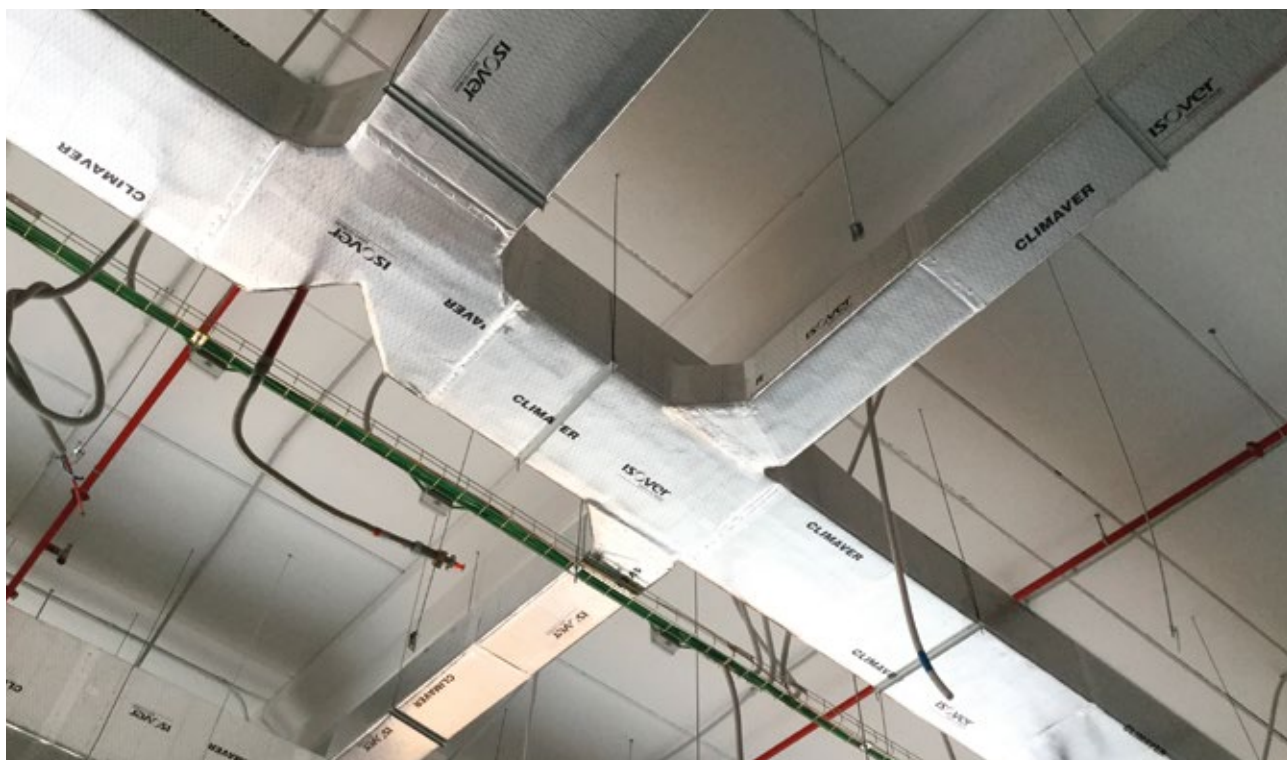
Instalacija kanala CLIMAVER® SDM oblik cipela
