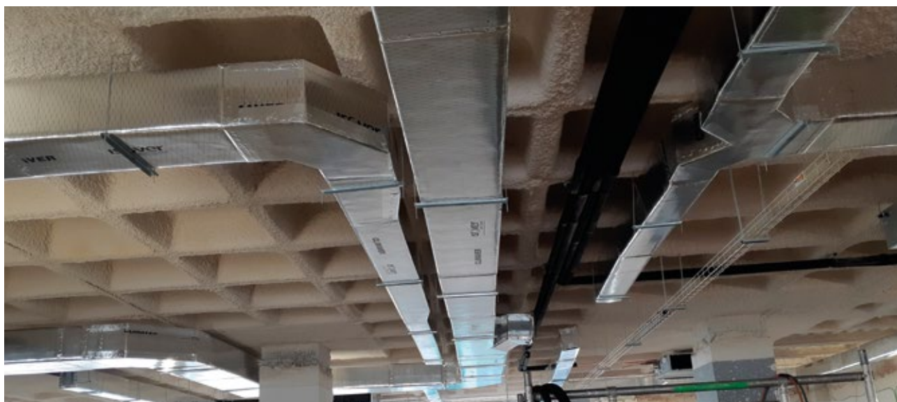
Instalacija kanala CLIMAVER® SDM redukcija
