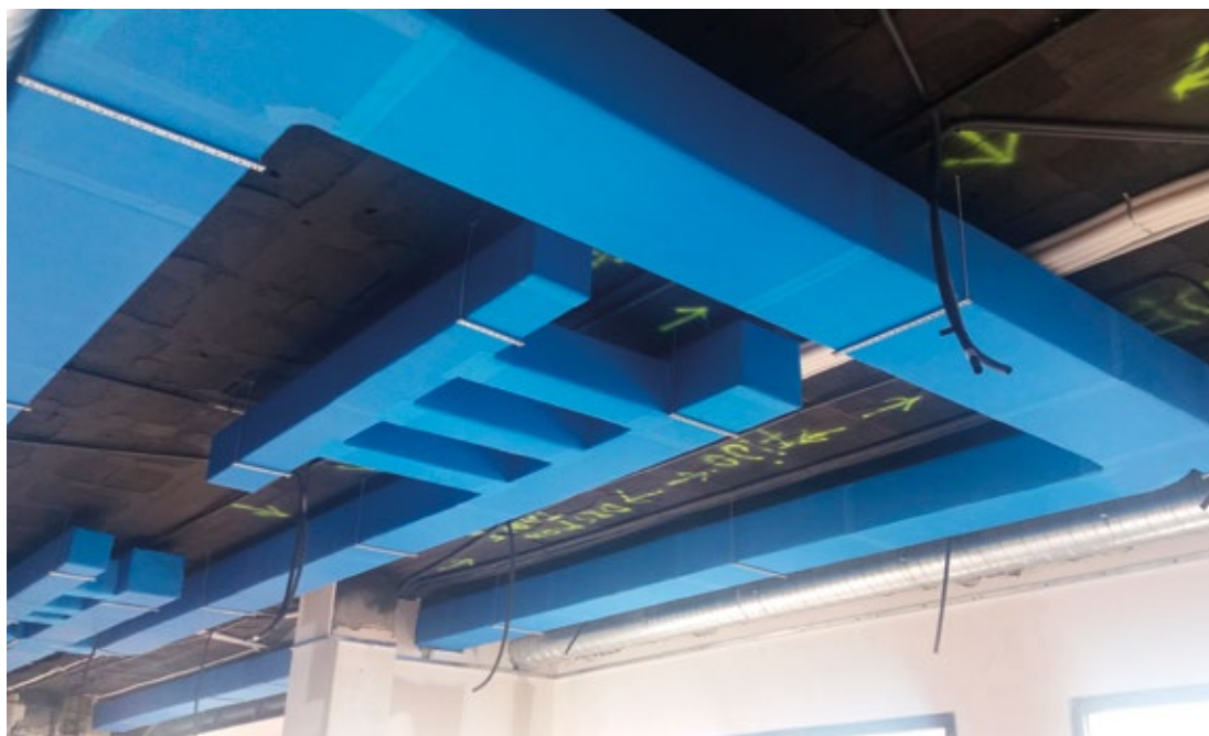
Nosač CLIMAVER® A2 DECO instalacije za ventilaciju
